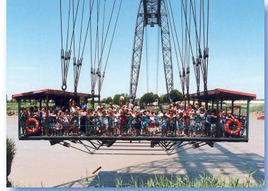
Le pont transbordeur
